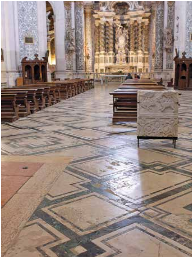
7 - Chiesa dei Gesuiti, pavimento in pietra d'Istria e verde Tessaglia, recentemente restaurato dalla ditta Giovanni Giusto (foto L. Fazzini).
