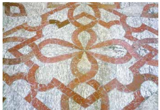
6 - Antonio Gaspari, Cà Pesaro (1710), pavimento di un pianerotolo dello scalone monumentale con in opera la varietà grigia della lumachella di San Vitale e broccato rosso di Verona (foto L. Lazzarini).
