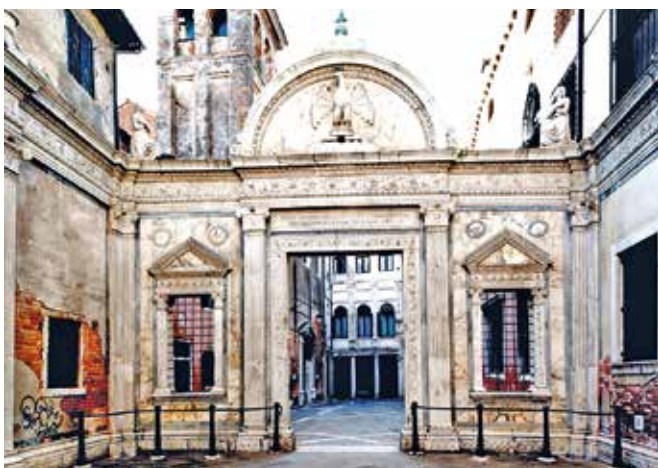
5 - Pietro Lombardo, septo (1481) della Scuola di San Giovanni Evangelista) con "telaio" e sculture in pietra d'Istria e marmo di Carrara (aquila), rivestito di pavonazzetto toscano, con cornici grigie di bardiglio (foto L. Lazzarini).
